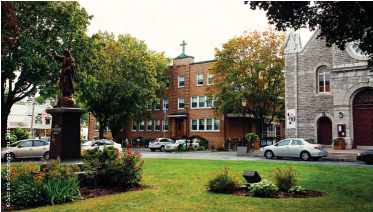
Résidence pour personnes âgées Florentine Dansereau à Verchères réalisée dans le cadre du programme AccèsLogis volet 2 et livrée en 2003.
